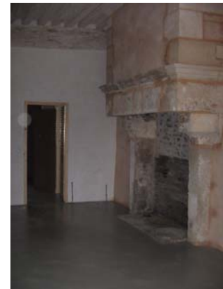
Cheminée XVIème (sol en béton ciré)
