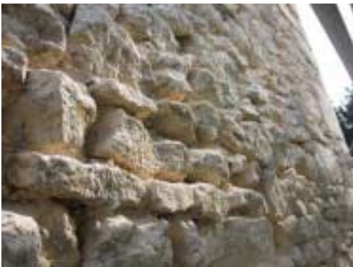
Mur gratté et en attente de l'enduit
