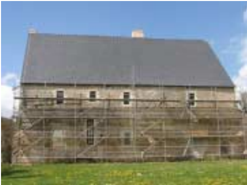
Façade Nord : linteau en cours de pose
