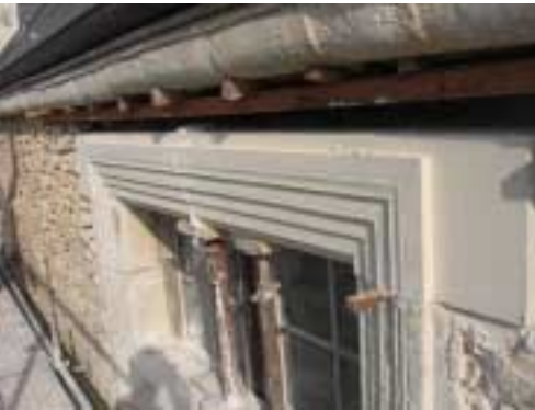
Mur gratté et en attente de l'enduit
